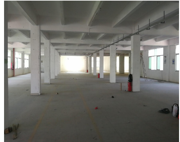
项目车间现状
