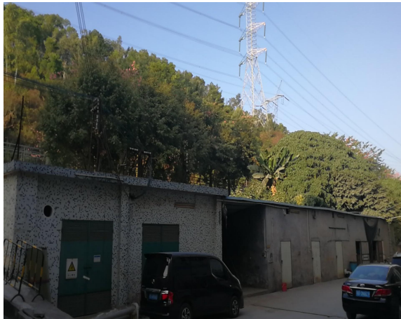
项目北面工业厂房
