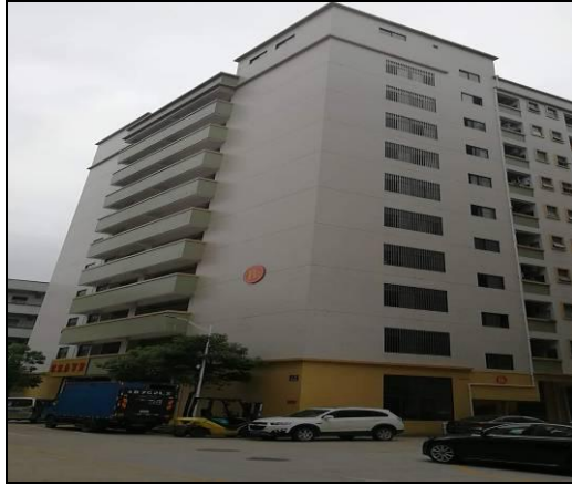
项目东面工人宿舍
