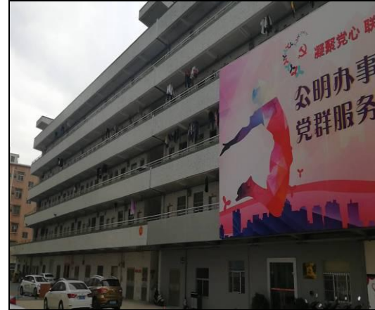
项目北面工人宿舍
